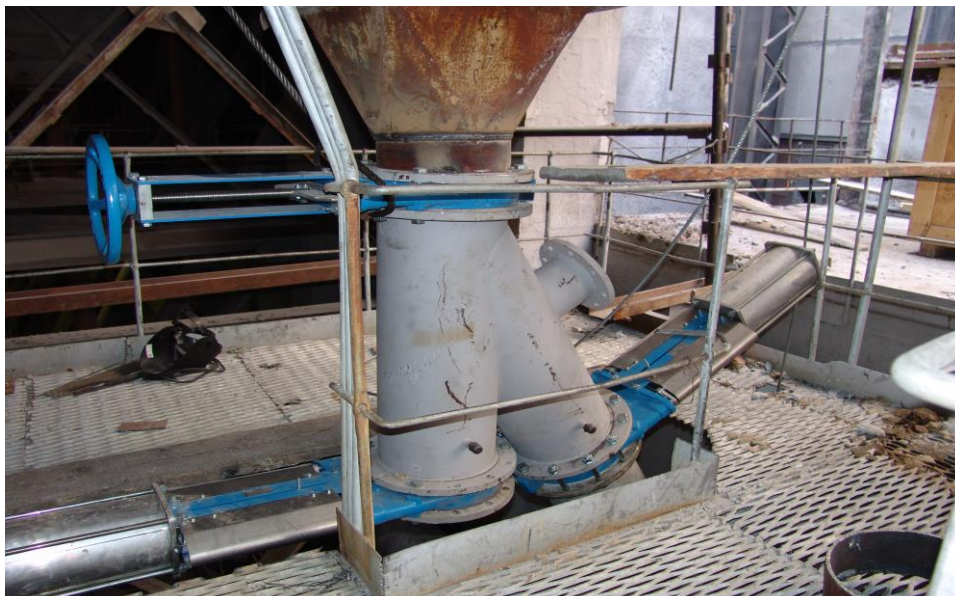
Рис.8. Пример решения золоспуска с ручной и пневмоприводной арматурой.
