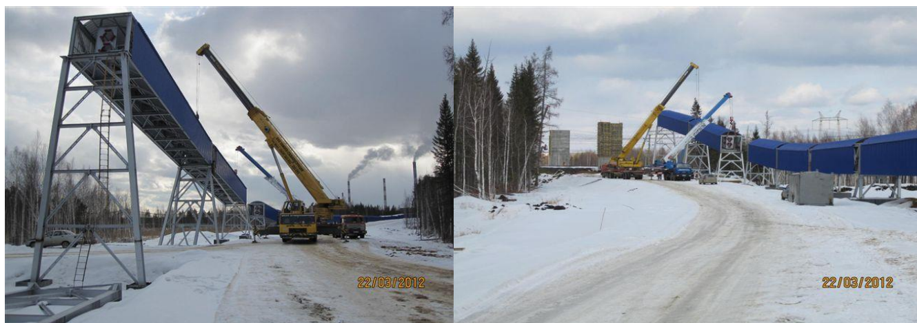
Рис. 46. Монтаж перехода ТЛК через магистральную ж/д.
