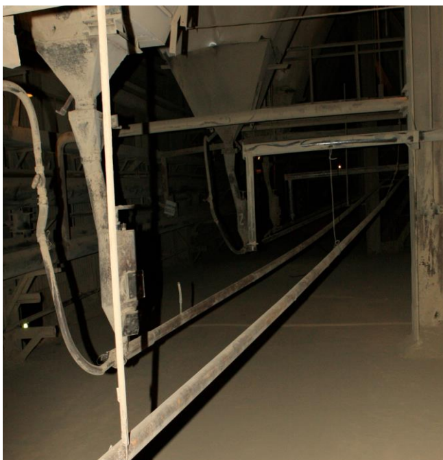
Рис.2,3. Система ПЗУ электрофильтров к/а ст. NN 1-2, на базе ПСН БГРЭС
